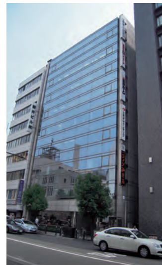
テナントビル
